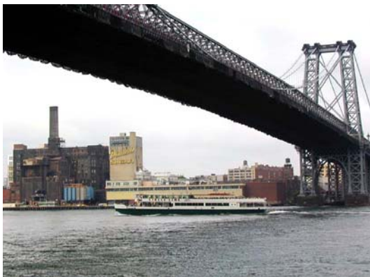
تصویر ۶- پل ویلیامزبرگ، مانهاتان (۳۰)
