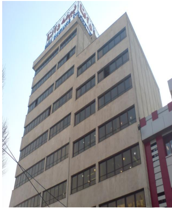
شکل ۲- نمای شمالی ساختمان (۵)
