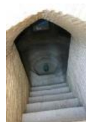
شکل ۷- سرداب خانه مرتاض Figure 7. The cellar of the Mortaz house
