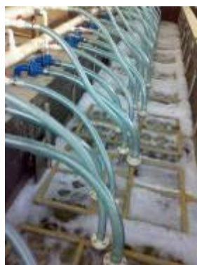
شکل ۲- سیستم MBR جریان مستغرق به منظور تجزیه بیولوژیکی پسماندهای شهری در کشور چین Figure 2. Submerged MBR system for biological decomposition of municipal solid waste in China
