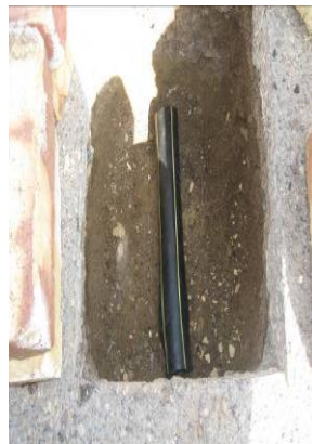
شکل ۴ آماده کردن کلیه‌ی کانال‌های خیابانی
