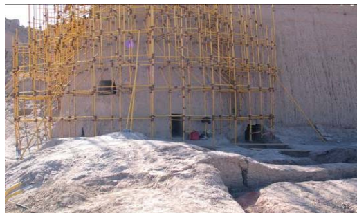
شکل ۱۱ گمانه‌های ۳ و ۴ در نمای خارجی برج. گمانه‌ی ۳ سمت‌راست تصویر و در تقاطع دیوار و برج، حفره‌ی ۱ از گمانه‌ی ۴ در میانه‌ی تصویر و حفره‌ی ۲ از گمانه‌ی ۴ سمت چپ و در میانه‌ی بدنه برج می‌باشند
