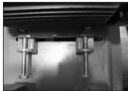
شکل ۱۱ کمپرسور نامیزان شده
