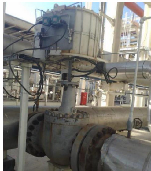
شکل ۲ شیر پرخشی (توپی) کلاس ۹۰۰ با محرک نیوماتیکی
