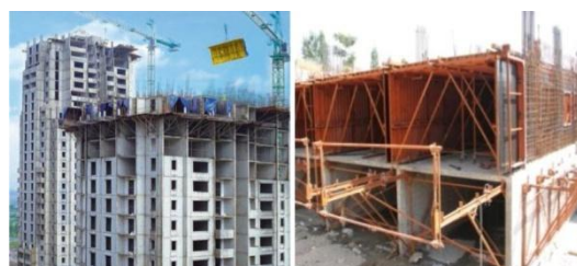
شکل ۱- قالب بندی سازه بتنی قالب تونلی
