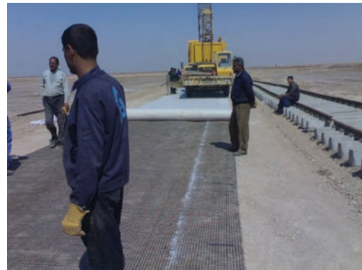
شکل ۳. روند نصب ژئوتکستایل و ژئوگرید
