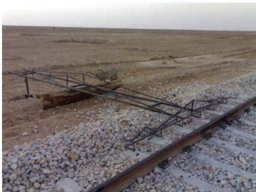
شکل ۴. خرپای ساخته شده برای نصب تغییر مکان‌سنج‌ها در پای ریل
