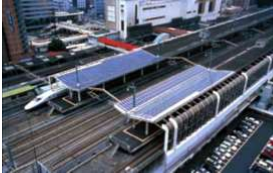
شکل ۵. نمونه پنل خورشیدی نصب شده بر روی سقف ایستگاه
