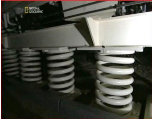
شکل ۱- نمایشی از فنرهای میراگر در مرکز کنترل و فرماندهی نوراد [۴]
