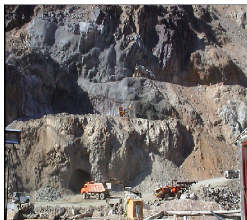
شکل ۱- مقطع حفاری تونل انحراف آب سد شهریار
