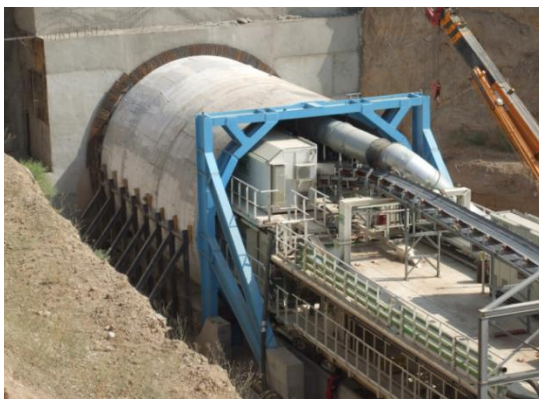
ب- نمایی از اجرای آن جهت شروع حفاری دستگاه TBM
