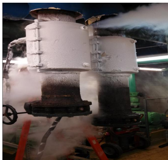
شکل (۳): انجماد سیال به وسیله دستگاه انجماد نوع پوشش محفظه فلزی
