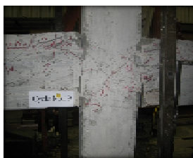
شکل ۱۰- ضعف در قطعه اتصال و جدا شدن تیرها از ستون سازه صلیب
