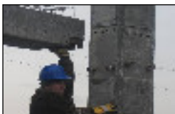
شکل ۴- نحوه‌ی اتصال تیر نیمه پیش ساخته به ستون
