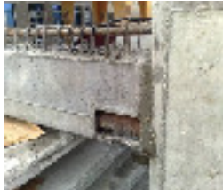
شکل ۵- پر کردن درز بین ستون و تیر نیمه پیش ساخته با گروت
