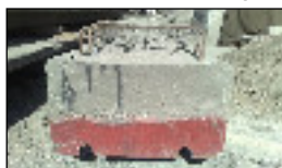
شکل ۳- بتن‌ریزی اولیه تیر نیمه پیش ساخته
