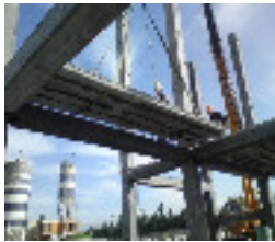
شکل ۶- نصب دال پیش ساخته مجوف پیش تنیده
