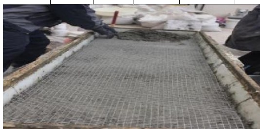
شکل ۸- کار گذاشتن مش فولادی و اجرای بتن ریزی
