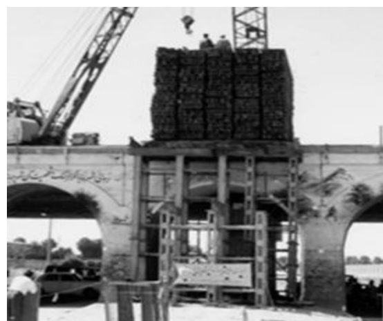
شکل ۲- بار گذاری استاتیکی پل اکبرآباد [۱۹]
