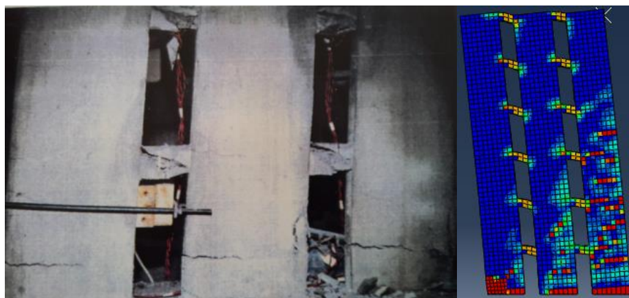
شکل ۸- مقایسه مود خرابی دیوار مورد مطالعه در آزمایشگاه و نتایج تحلیل نرم افزار [۵]
