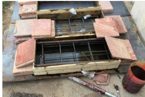
شکل ۶- آماده‌سازی و روغن زدن قالب‌های چوبی
