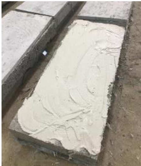
شکل ۹- آغستن سطح دال به مخلوط چسب جهت چسباندن ورقه بتن توانمند الیافی
