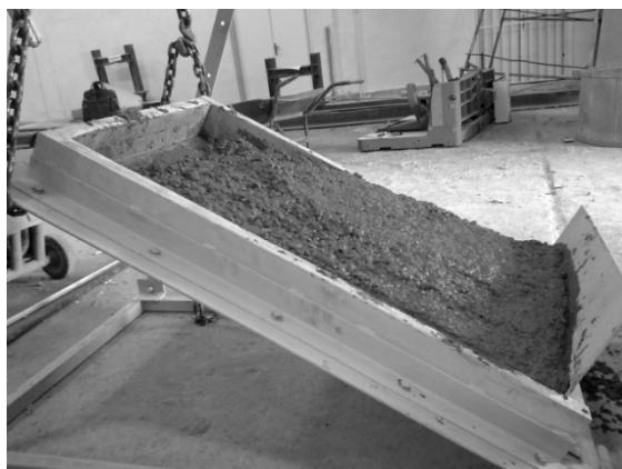
شکل ۵- بتن بر روی شیب ۳۰ درجه شره کرده و باعث جداشدگی سنگ‌دانه‌ها شده است
