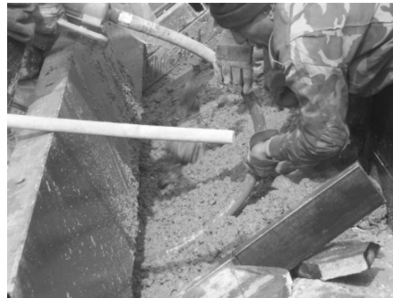
شکل ۱۱- روش جایگزین، اجرای یک درمیان پانل‌های بتنی به وسیله‌ی قالب ثابت
