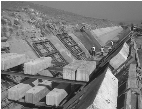
شکل ۱۱- روش جایگزین، اجرای یک درمیان پانل‌های بتنی به وسیله‌ی قالب ثابت
