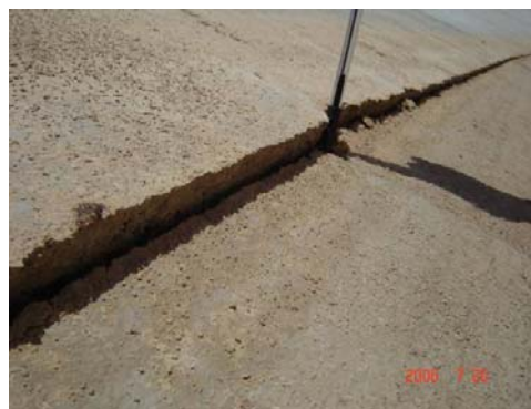
شکل ۱- تصویری از محل‌های آسیب دیده و شکل شماتیک
