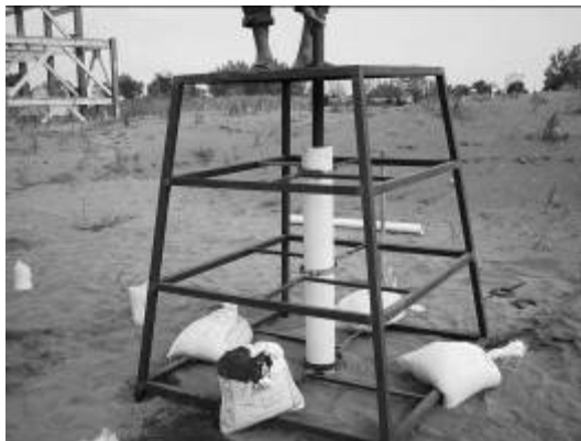
شکل ۴- هدایت لوله فولادی به درون غلاف
