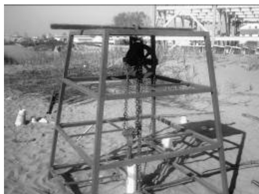
شکل ۵- تجهیزات خارج کردن غلاف از داخل خاک
