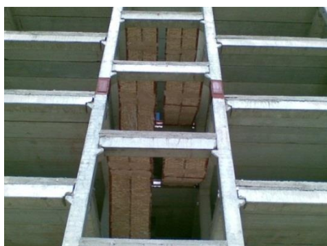
شکل ۱- اتصال تیر به ستون پیش‌ساخته رایج در ایران
