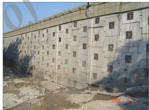
شکل ۱. سیستم ترکیبی موازی متشکل از خاک مسلح با تسمه و میخکوبی در حالت موازی (۱)
