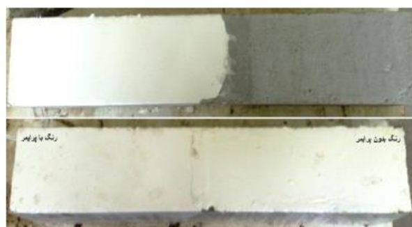
شکل ۱۲. نحوه‌ی اجرای رنگ بر سطوح بتنی
