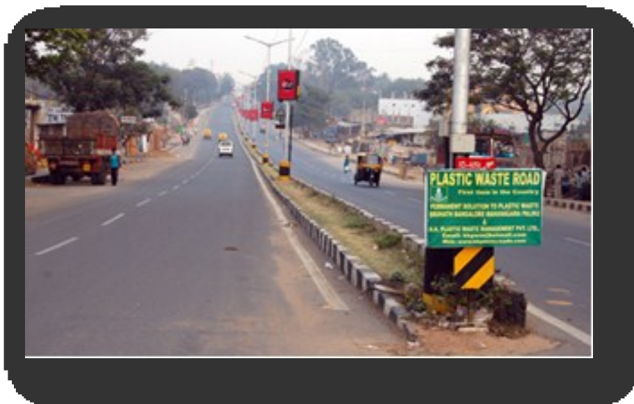
شکل ۱. جاده‌ی ساخته‌شده از پلاستیک بازیافتی
