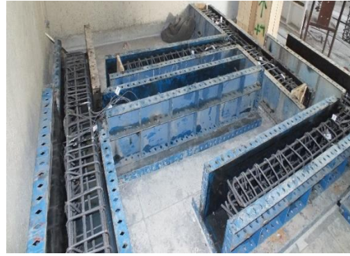
شکل ۴. قالب بندی سه نمونه اتصال ساخته شده
