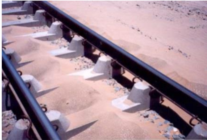
شکل ۳- نمونه‌ای تست شده از تراورس کوهاندار [2]
