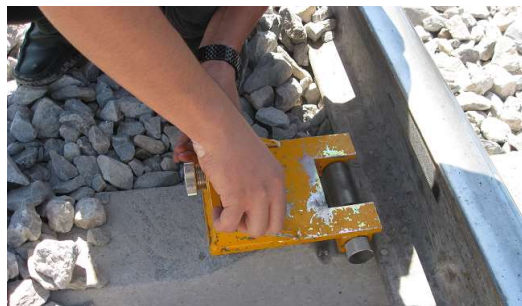
شکل ۵: اتصال پایه جک با کمک قطعه واسطه به تراورس.
