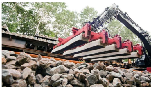
شکل ۳: جایگذاری تراورس‌های مجهز به پد زیر تراورس.
