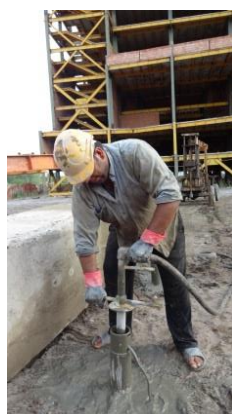
شکل ۹: عملیات تزریق در شمع پیچی.
