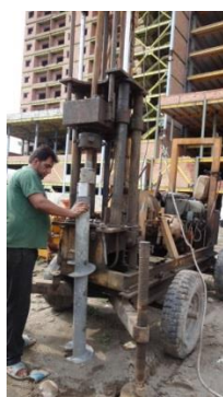
شکل ۷: اجرای شمع‌های پیچی پره دار.
