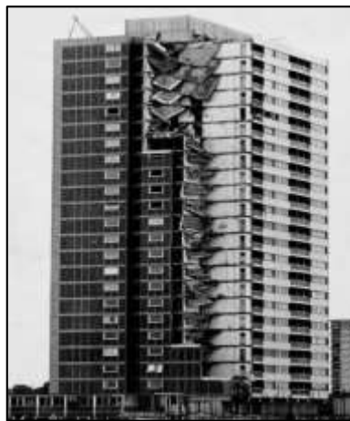
شکل ۱: فروریزش ساختمان رونان پوینت در سال ۱۹۶۸ [۱].
