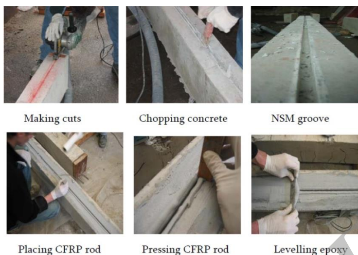
شکل ۱: مراحل کاشت آرماتورهای NSM در پوشش بتن.
