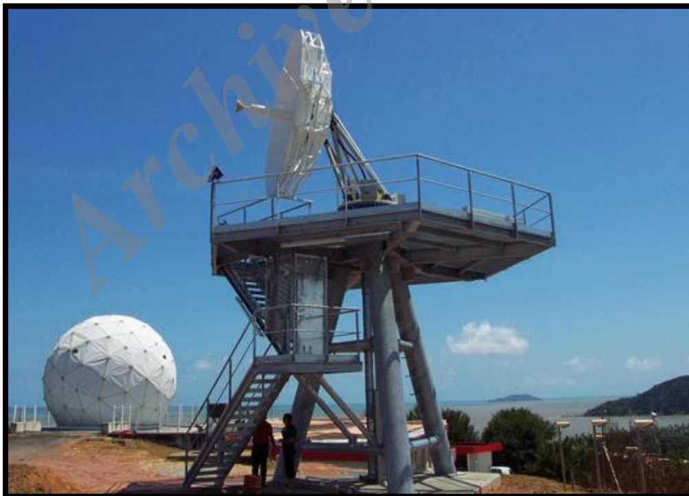
شکل ۱: سکوی چند منظوره جهت استقرار پدستال آنتن.
