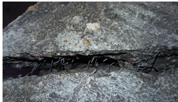
شکل ۱۰: گسیختگی الیاف فولادی در اثر اعمال نیرو بعد از شکست
