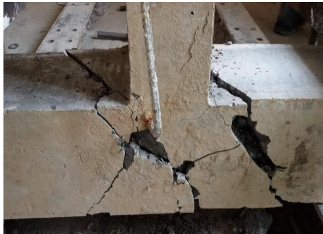
شکل ۹: حالت شکست پیچشی بتن با ۰/۷۵ درصد الیاف
