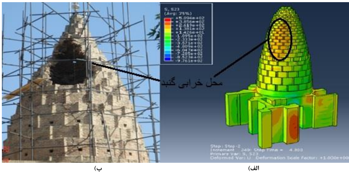
شکل ۱۰: الف) تنش برشی گنبد گام سوم تحت تحلیل دینامیکی (ب) محل خرابی گنبد در زلزله ۱۳۸۵ دشت سیلاخور
