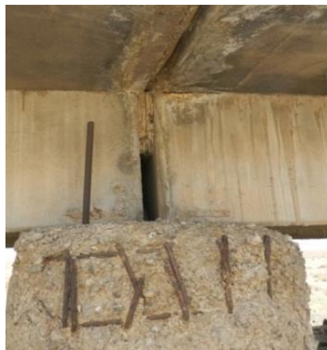
شکل ۲: آثار خوردگی در برخی از پل‌های بتنی مورد بررسی در استان خراسان رضوی
