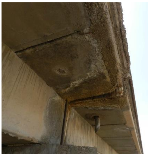
شکل ۲: آثار خوردگی در برخی از پل‌های بتنی مورد بررسی در استان خراسان رضوی
