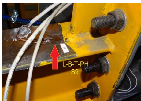
شکل ۱۲: نصب کرنش‌سنج روی بال فوقانی تیر در محل مفصل پلاستیک.
