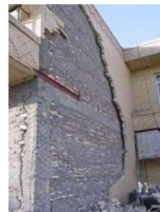
شکل ۱: فروریختن نمای آجر سه سانتی به علت نداشتن اتصال مناسب به میانقاب آجری [۲].
