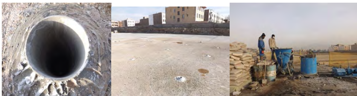
شکل ۱۱: (الف) شبکه ۳*۳ تزریق انبوهی-بلوک ۲، (ب) لوله PVC جهت سرچاهی، (ج) ست تزریق دوغاب
