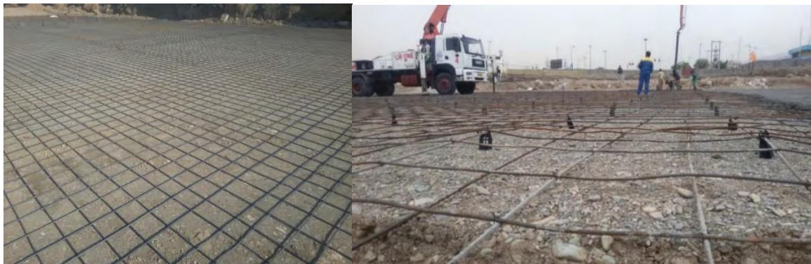
شکل ۹: شبکه آرماتور جهت بتن مگر - بلوک ۳ و عملیات بتن ریزی بر روی خاکریزها - بلوک ۱
