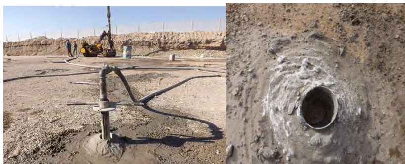
شکل ۱۲: تزریق دوغاب به گمانه‌های انبوهی و یک گمانه تزریق شده- بلوک ۲
