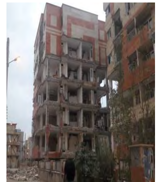
شکل ۳: عدم مهار مناسب میان‌قاب‌ها و اجزای غیرسازه‌ای و آسیب‌های آن در زلزله ۲۱ آبان ماه کرمانشاه ۱۳۹۶
