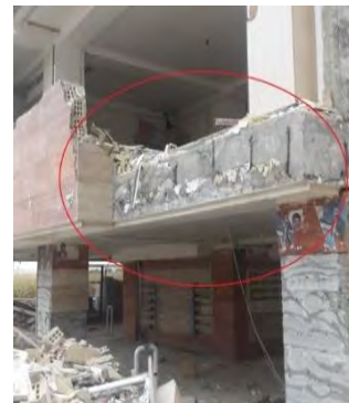
شکل ۳: عدم مهار مناسب میان‌قاب‌ها و اجزای غیرسازه‌ای و آسیب‌های آن در زلزله ۲۱ آبان ماه کرمانشاه ۱۳۹۶
