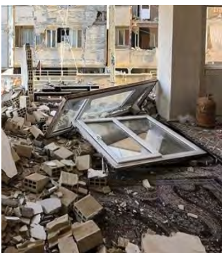
شکل ۳: عدم مهار مناسب میان‌قاب‌ها و اجزای غیرسازه‌ای و آسیب‌های آن در زلزله ۲۱ آبان ماه کرمانشاه ۱۳۹۶
