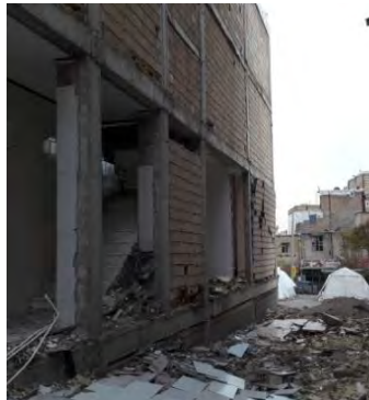
شکل ۳: عدم مهار مناسب میان‌قاب‌ها و اجزای غیرسازه‌ای و آسیب‌های آن در زلزله ۲۱ آبان ماه کرمانشاه ۱۳۹۶
