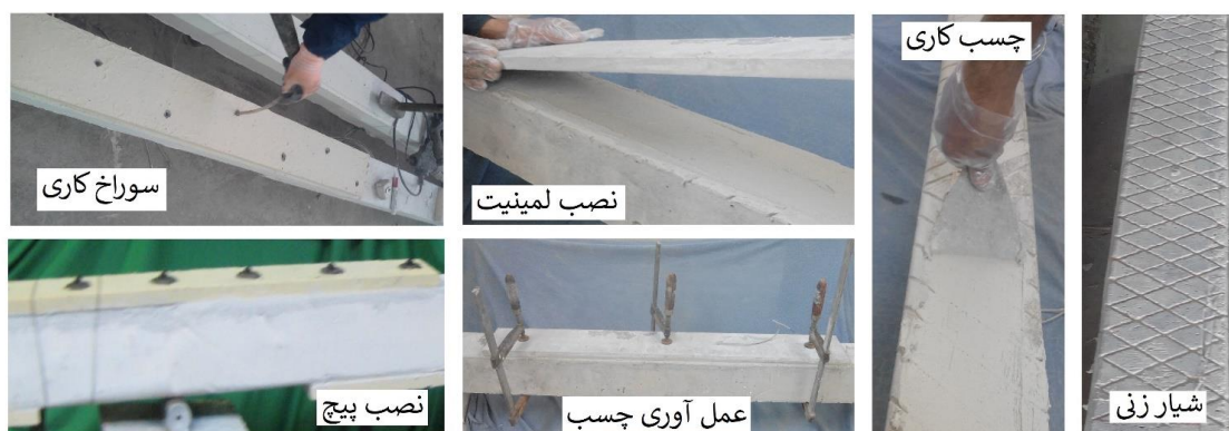
شکل ۸: نصب لمینیت‌ها روی تیرها
