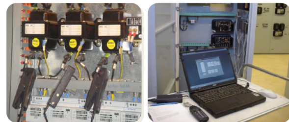
شکل ۲۱: اندازه‌گیری عملی هارمونیک‌های جریان ورودی
