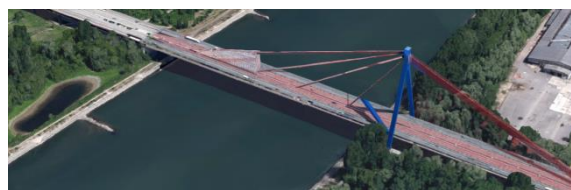
شکل ۱ استفاده از دو آبشکن برای حفاظت کوله پل روی رودخانه راین در استان بادن ووتنبرگ آلمان.
