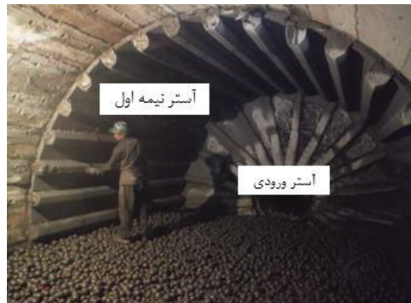
شکل ۹: نصب آستر طرح پیشنهادی برای آسیای گلوله‌ای اولیه ۴
