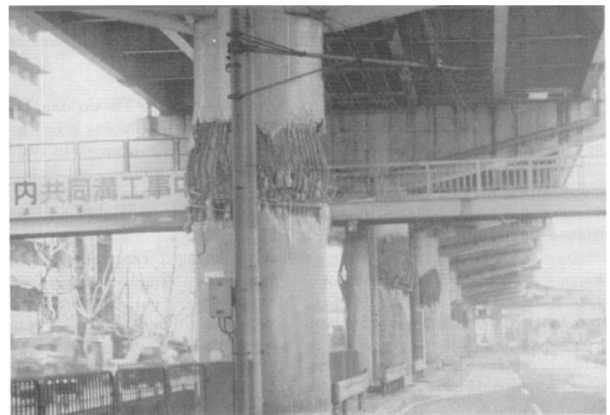
(الف) شکست فشاری پایه‌های پل هانشین [۶]
