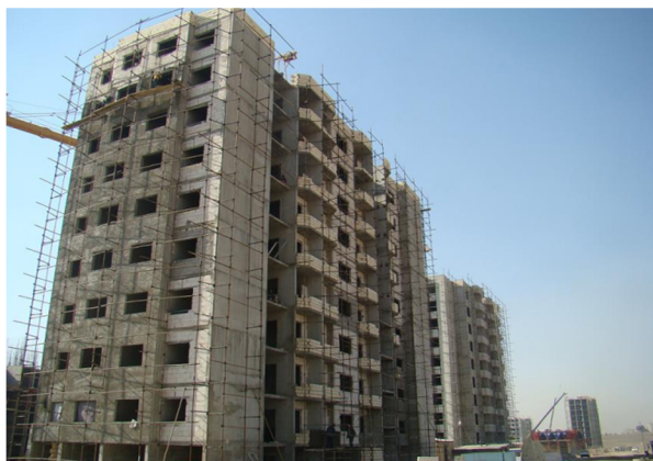
شکل (۱): نمونه‌ی ساختمان‌های قالب‌تولنی احداث‌شده در ایران (پروژه ۲۵۳۰ واحدی پردیس بومهن)
