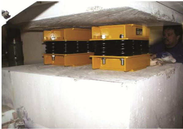
شکل (۱۲): تکیه‌گاه فبری برای ایجاد جداسازی در راستای قائم و افقی (جداسازی سه‌بعدی).
