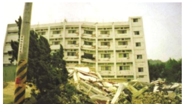
شکل (۴): رسیدن گسلش به زیر پی و آسیب جدی ساختمان [۱۰].
