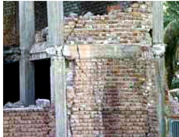
شکل (۱۲): شکست برشی تیر بتن مسلح به علت اندرکنش با دیوار پرکننده آجری (بم - ۱۳۸۲).
